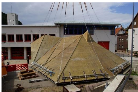
Abhub des originalen Islerdaches, Geislingen a.d.Steige (Veit Gmehlich, Heinz Isler, 1969-2014, BRD)
